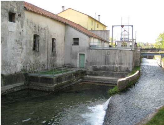
Centrale ex Ziche
