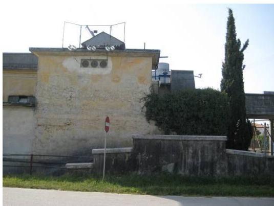
Centrale ex Cascami
