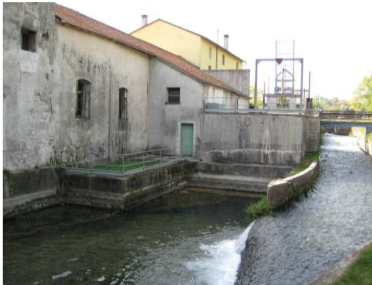
Centrale ex Ziche
