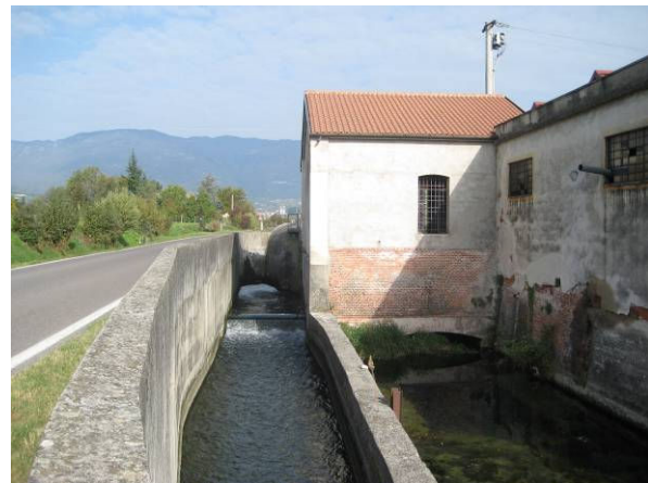
Centrale ex Binotto
